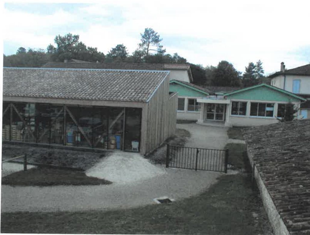
Bâtiments nouveaux, l'école.
