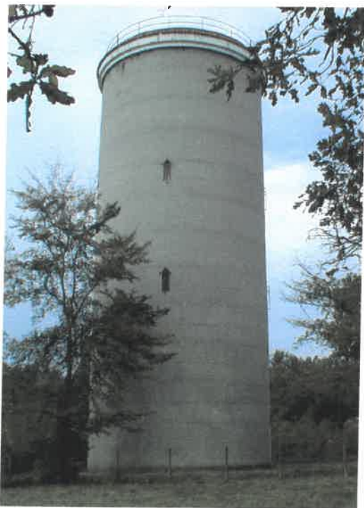
Le château d'eau
