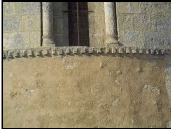
Fig. 657 Appareil en petits moellons et appareil régulier de l'abside.
