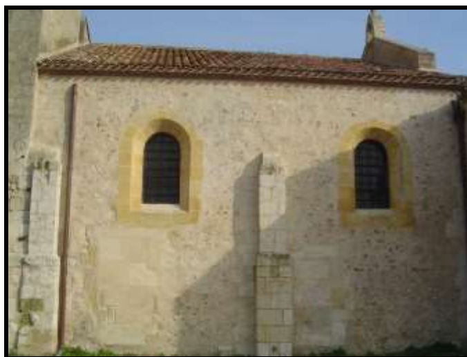
Fig. 122 Vue du mur sud en moellons.
