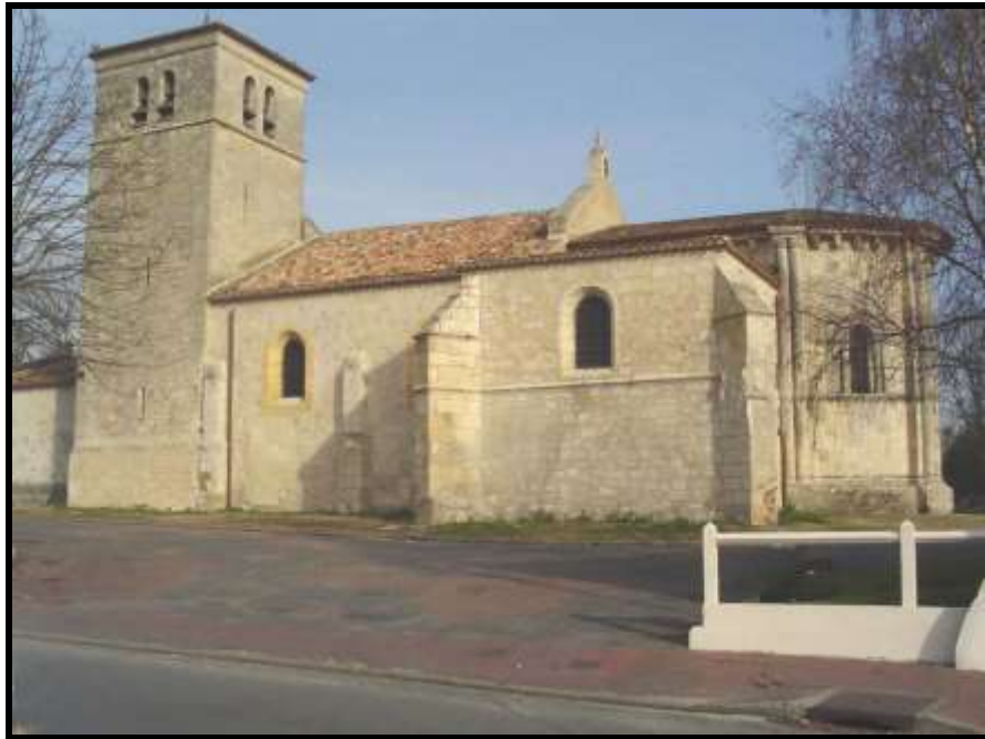
Fig. 121 Vue générale côté sud.
