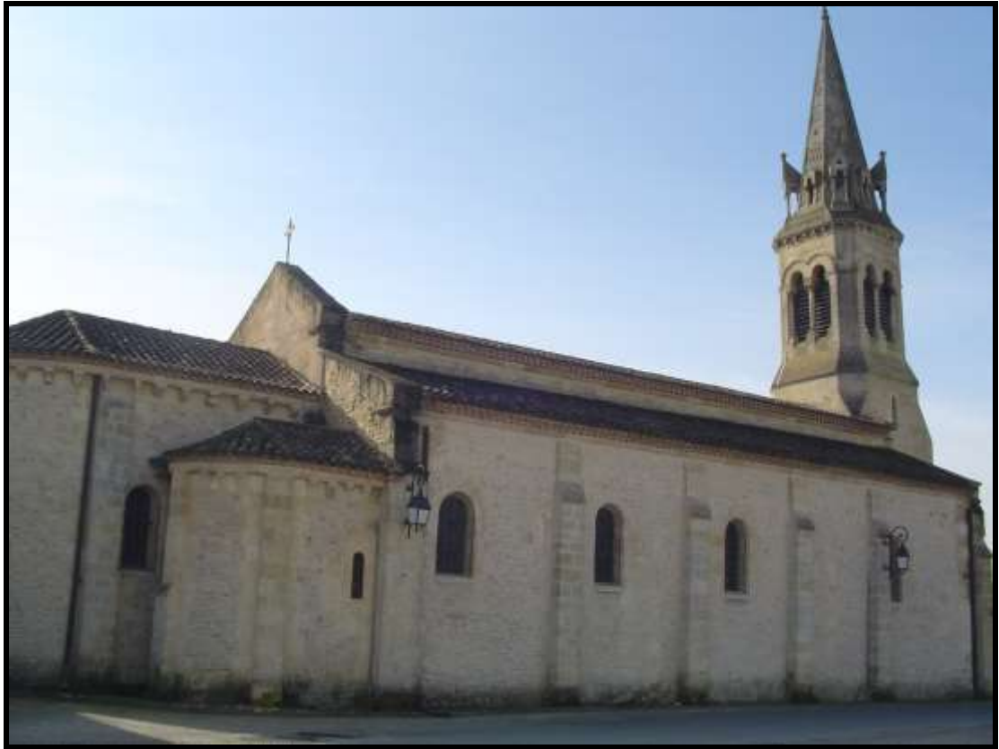
Fig. 98 Vue du nord.
