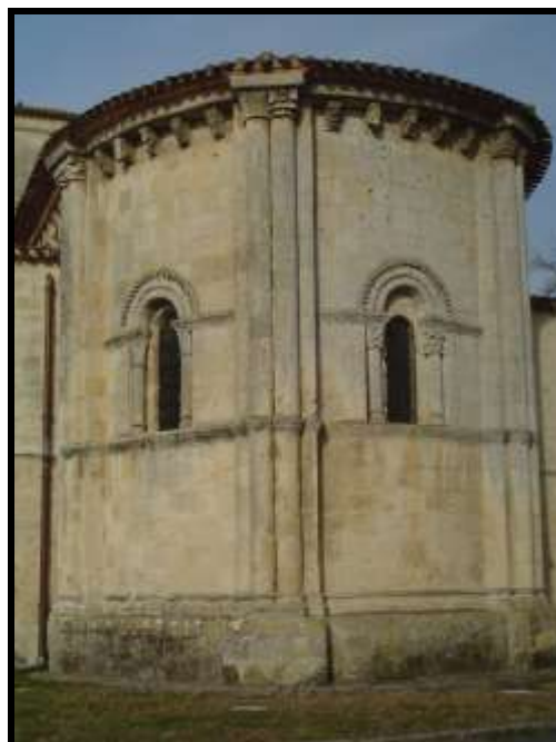
Fig. 124 Vue de l'abside principale.
