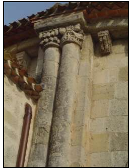
Fig. 127 Colonnes et chapiteaux de l'absidiole sud
