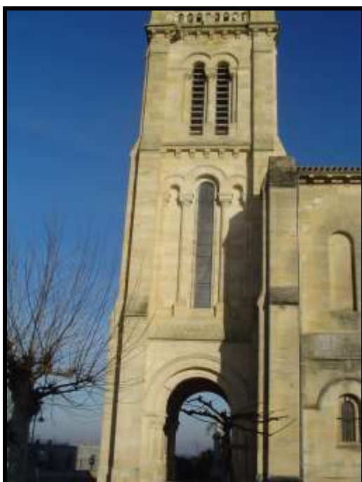
Fig. 450 Clocher porche vu du sud.
