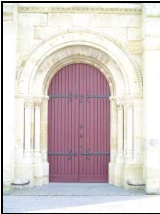
Fig. 99 Portail principal de l'église.
