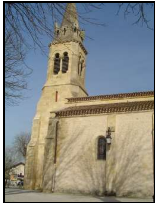
Fig. 100 Vue sud du clocher.
