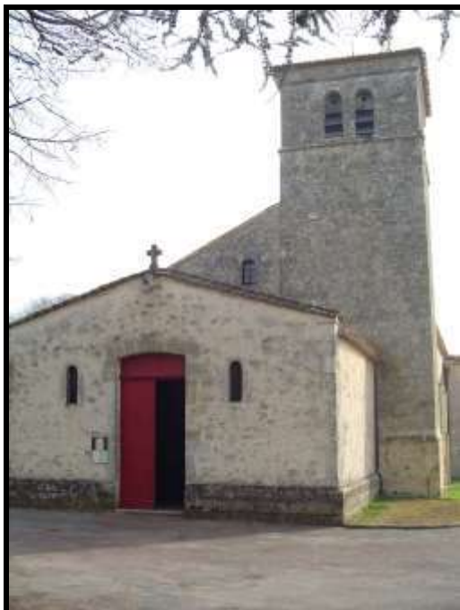
Fig. 123 Vue de la façade occidentale.
