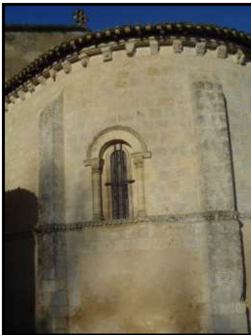
Fig. 153 Abside avec les contreforts et baie.
