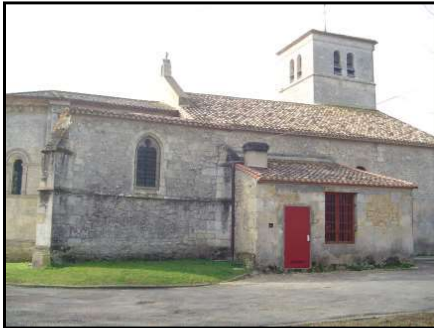
Fig. 122 Vue générale côté nord.
