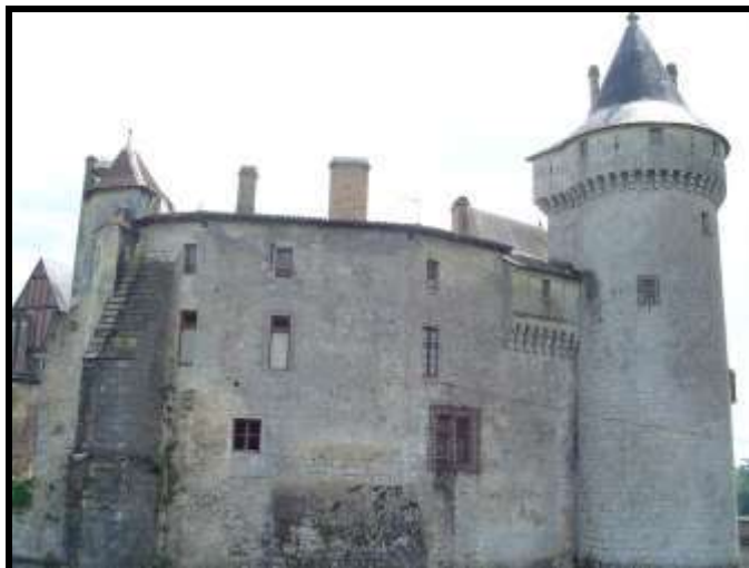
Fig. 55 Bâtiment d'habitation et ancienne tour du XIII ème .
