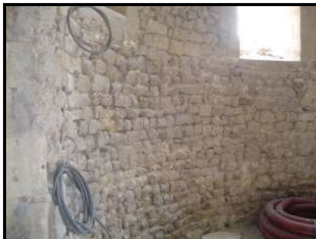
Fig. 76 Appareil intérieur de l'absidiole sud en moellons.
