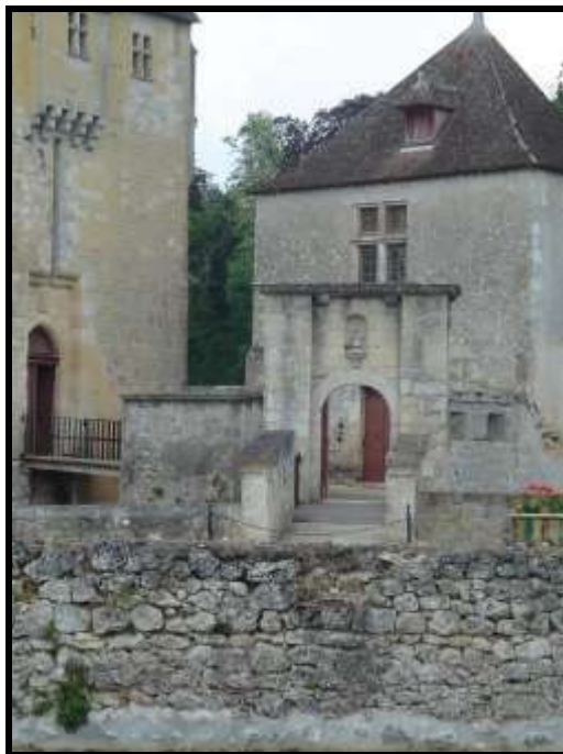
Fig. 53 Entrée du château, ancienne barbancane.
