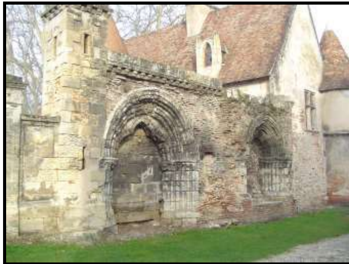
Fig. 89 Façade du prieuré.
