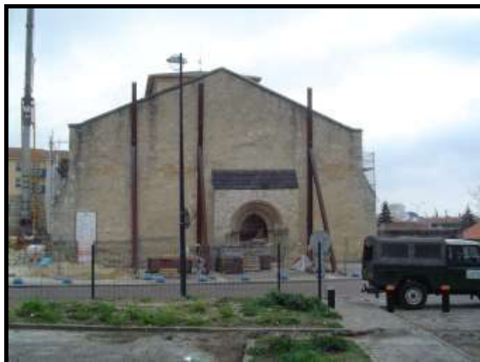
Fig. 66 Façade occidentale de l'église en travaux.
