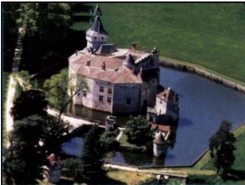
Fig. 51 Château vu du ciel.
