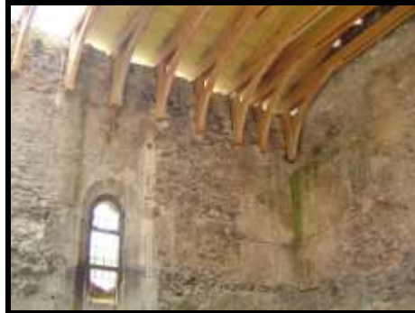
Fig. 73 Nouvelle charpente de la nef centrale.
