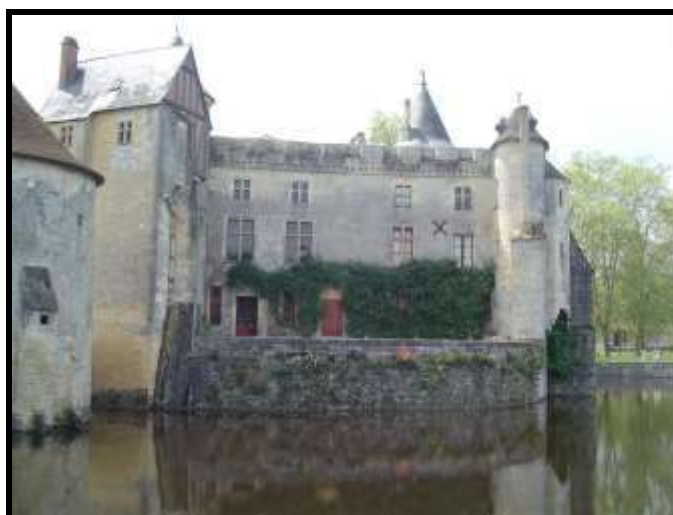
Fig. 54 Bâtiment d'habitation, enceinte détruite.
