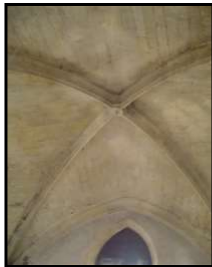
Fig. 75 Voûte d'ogives intacte dans sud.
