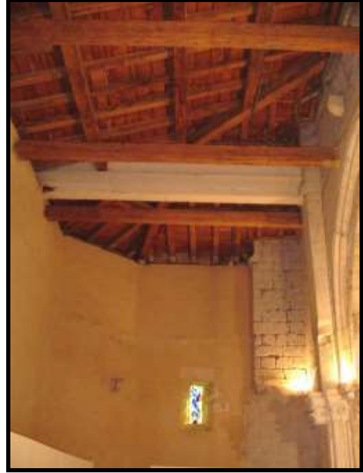
Fig. 97 Bas-côté nord charpenté
