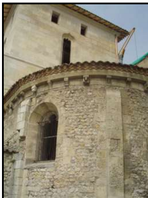
Fig. 69 Vue de l'abside en moellons et du clocher tour.
