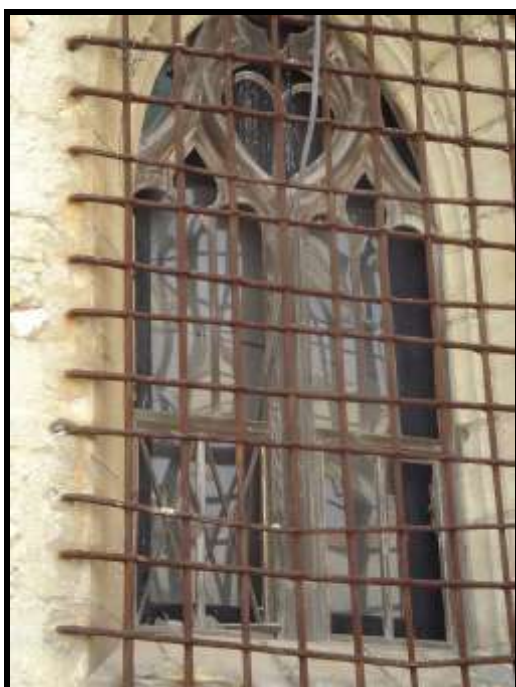
Fig. 68 Fenêtre ogivale avec remplages en bois.
