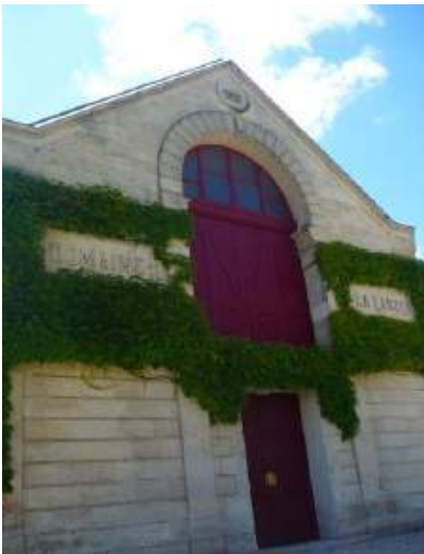
Bâtiment de la cuverie
